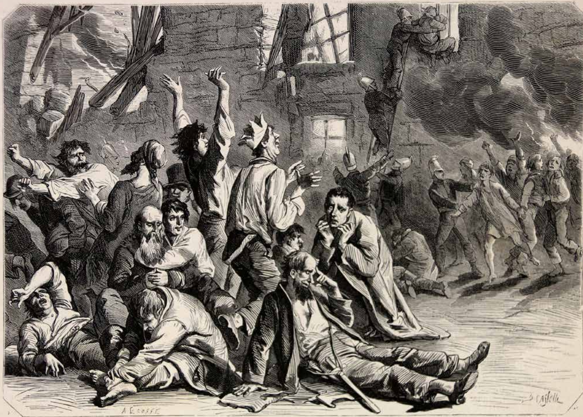
Incendie de la Maison des fous, à Nice.
